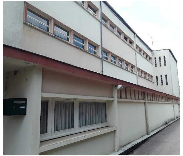
Mur extérieur Primaire
