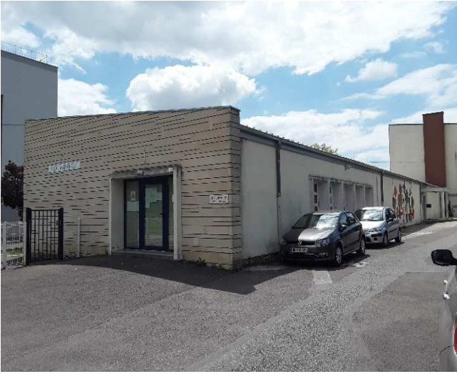
Mur extérieur maternelle
