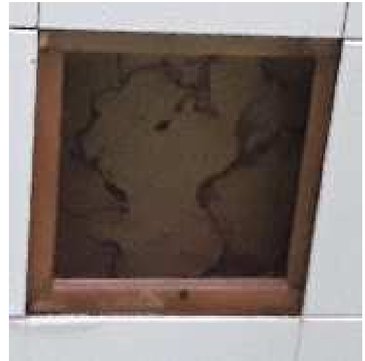
Isolation sous rampant toiture école primaire
