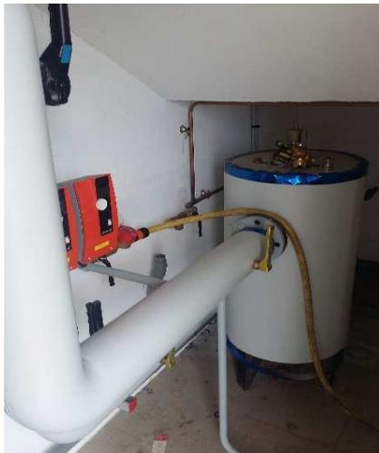
Circulateurs chauffage et pot à boue
