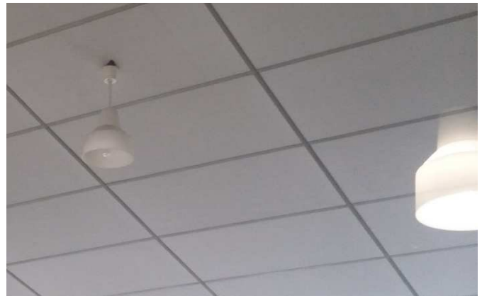
Faux plafond st Exupéry 2
