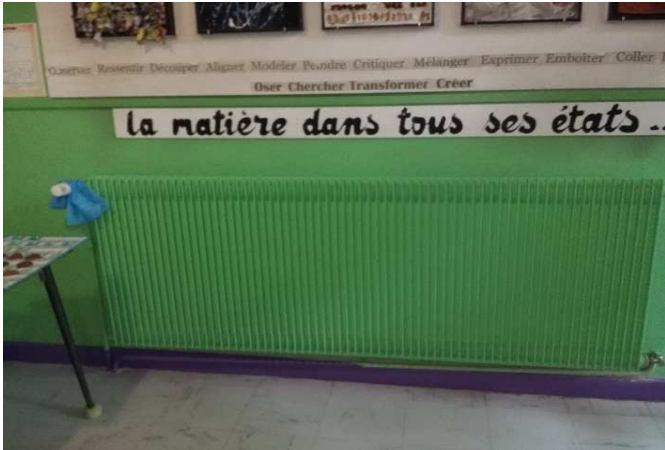
Radiateur acier à éléments avec robinet thermostatique
