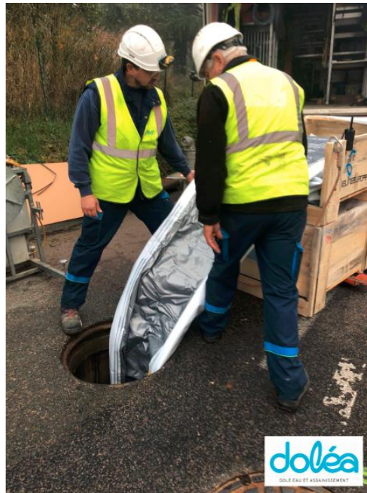
Chemisage - Rue des Sources - Goux
