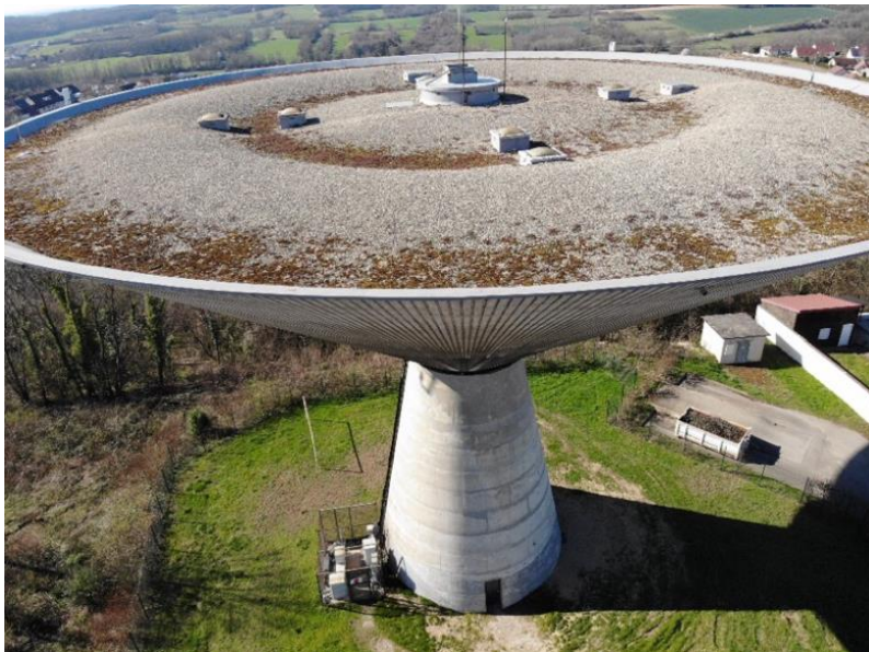
Réservoir de Plumont - Trappe d'accès au dôme
