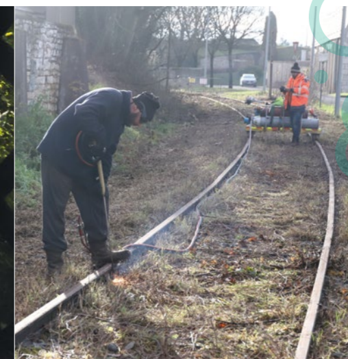
Travaux sur la voie Grévy
