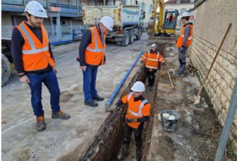
Sur le chantier de la rue Faustin Besson, ce mercredi 20 novembre. Photo Serge Dumont
