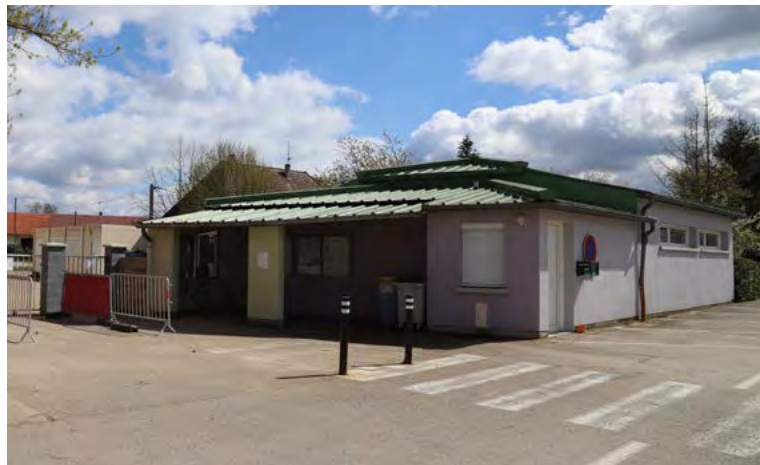
Accueil de loisirs du Deschaux
