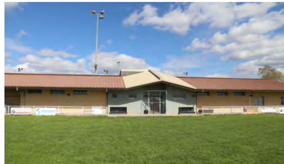
Vestiaires du Stade de la Pépinière à Damparis
