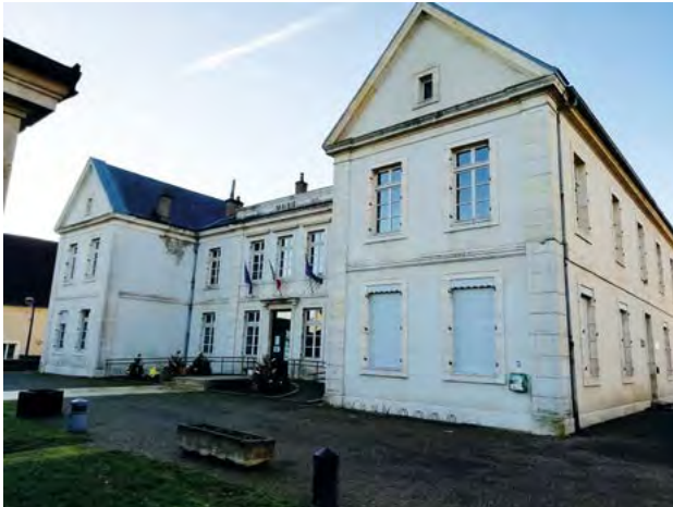
Rénovation de la toiture de la Mairie / Saint-Aubin
